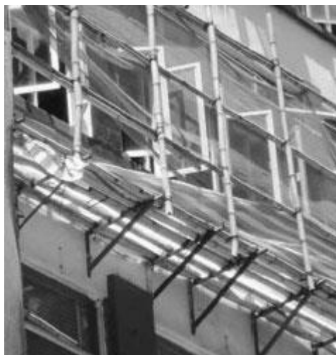
“ I ”型「狗臂架」最低的螺絲位置與窗口邊緣距離太遠，因此沒有安裝
